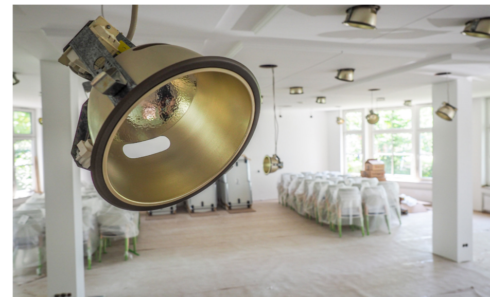
Stühle und Tische sind da, der Boden ist fertig und die Lampen warten auf die Endmontage. Bald kann im Großen Saal wieder gefeiert werden.
